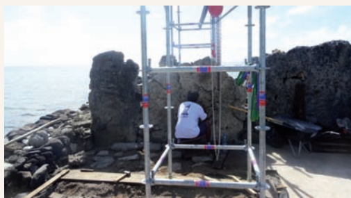
Restauration d'une pierre corallienne - Site de Taputapuatea
